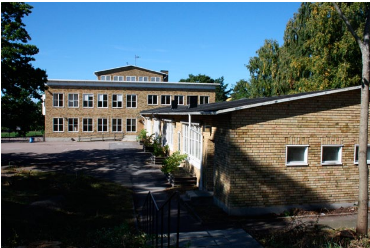
Den pagodlika mittdelen med tätt sittande fönster och närmast den östra flygeln.
