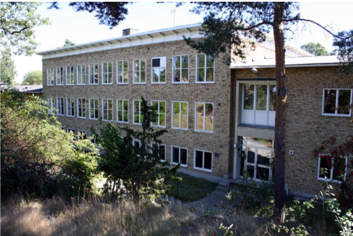
Norrfasaden med huvudentrén och dess marmoromfattning. Mittdelens speciellt utformade takfot är oerhört karaktärskapande.
