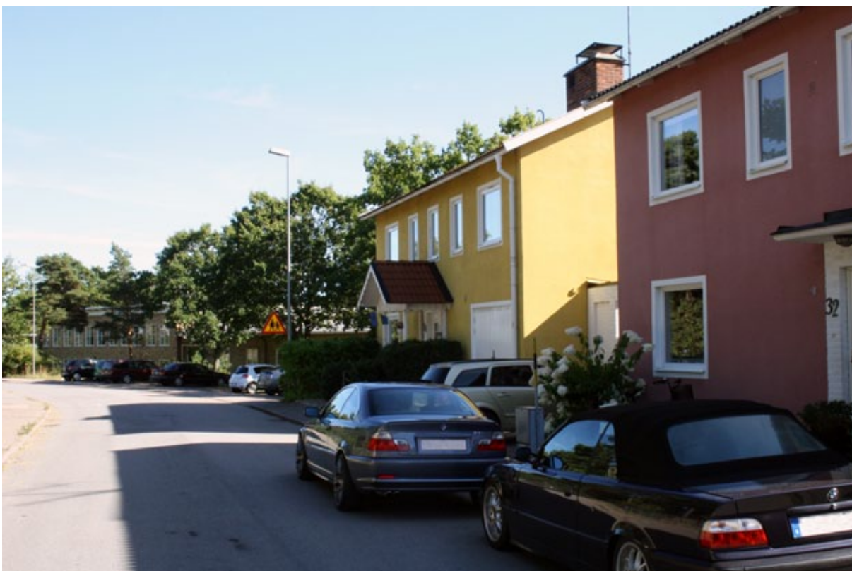
Kedjehusen på Solbackavägen, direkt väster om skolan, ritades av Nils Kårbo 1953. Kikeboskolan som syns i bakgrunden är inte alla lika monumental åt norr eftersom den anlades nedanför bergkanten.
