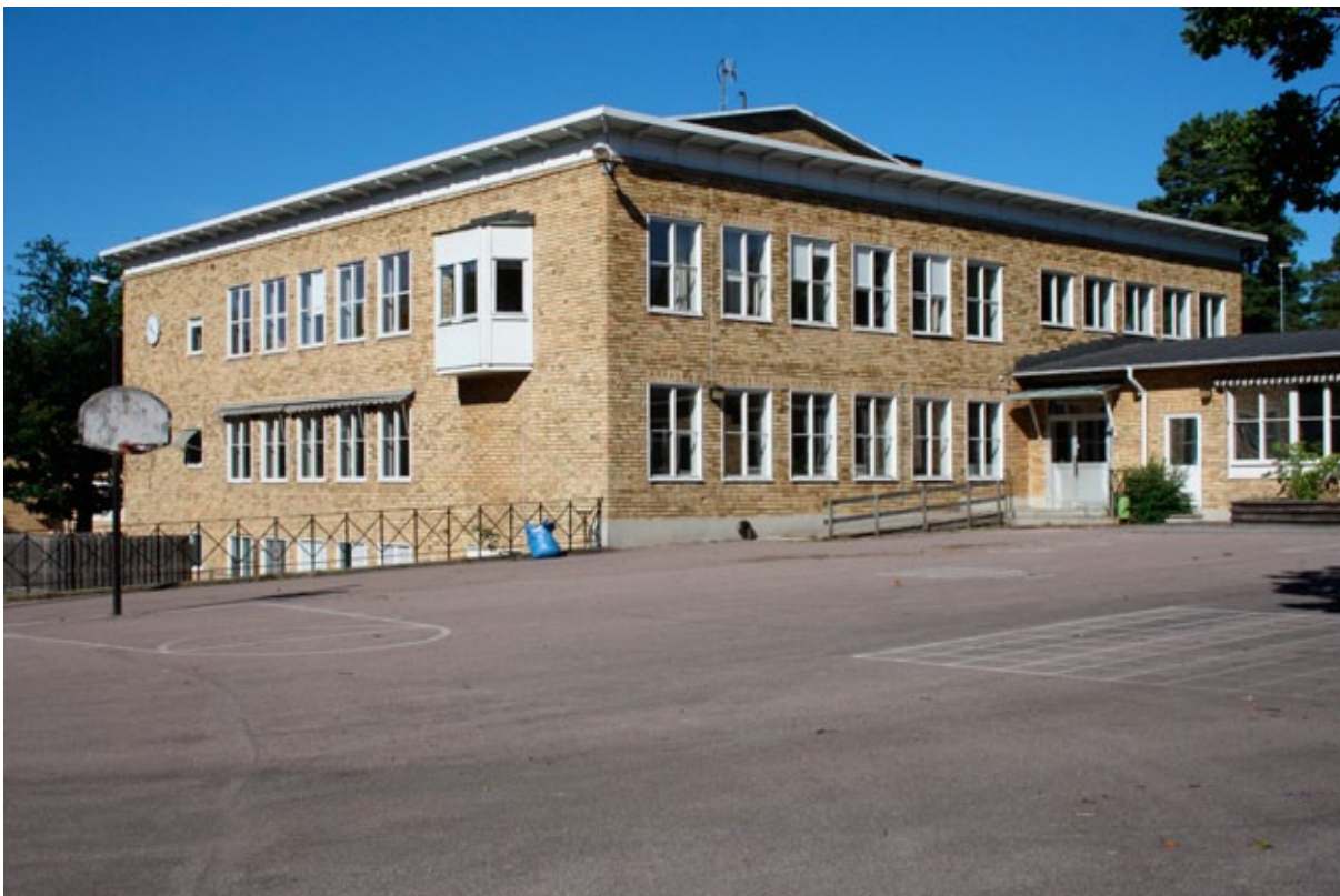
Burspråket tillhörde lärarrummet, här anas även den kraftiga terrasseringen.
