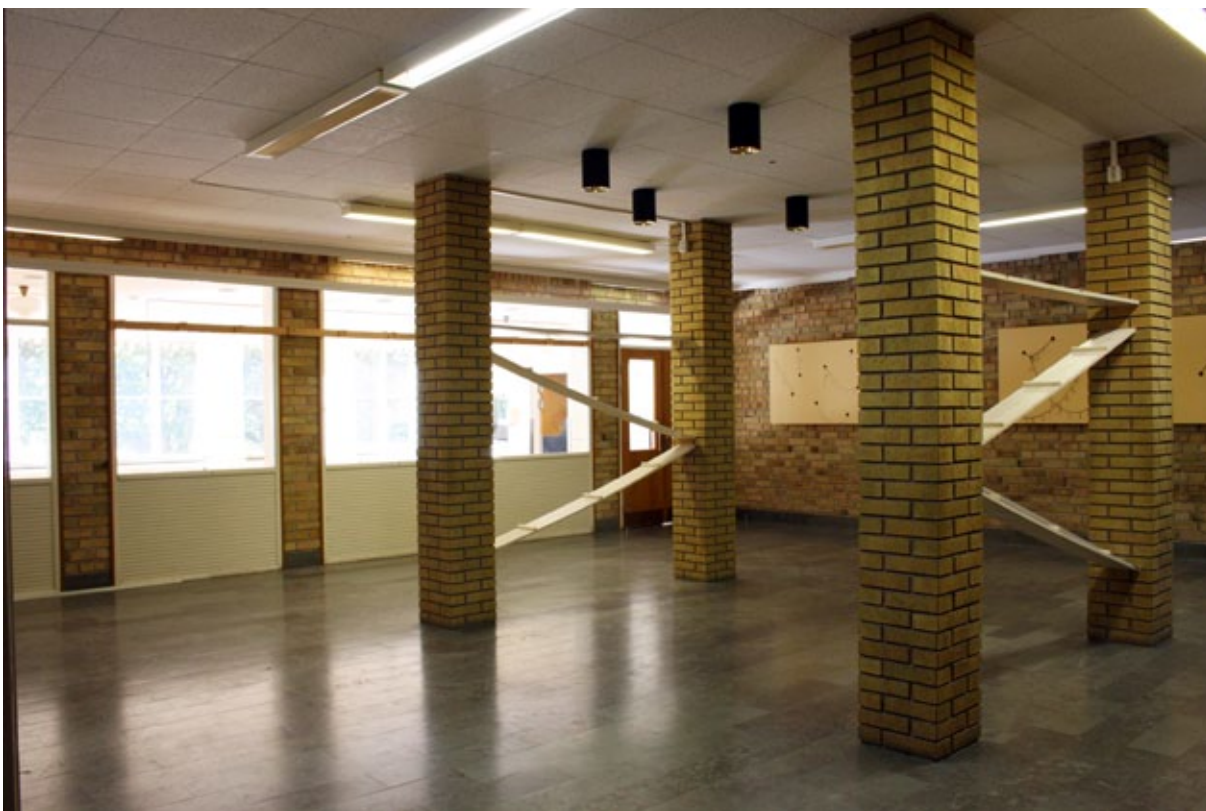
Den s.k. ljushallen i mittkroppens första våning fick sitt namn genom det rikliga ljus som nedkom från lanterninen. I början av 1980-talet sattes dock öppningen igen och för att bära bjälklaget tillkom de fyra tegelpelare som syns på bilden. I bakgrunden är matsalen.
